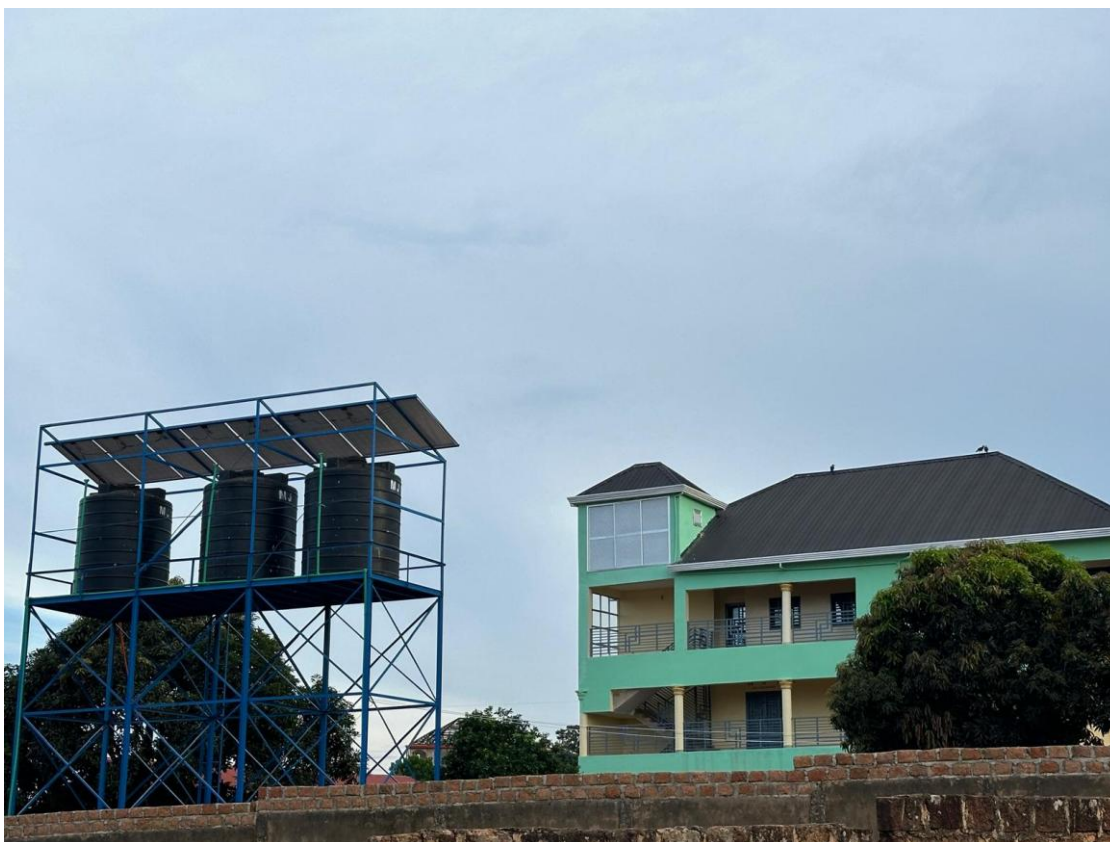
Figure 5 : Le centre de formation et d'apprentissage aux métiers (CFAM), avec l'installation d'adduction d'eau potable.
